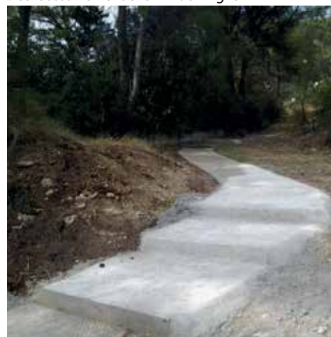
Elagage et maçonnerie chemin des Ladres - Après
