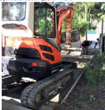
Maçonnerie les Valouches - Pendant
