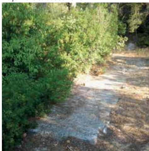
Elagage et maçonnerie chemin des Ladres - Avant
