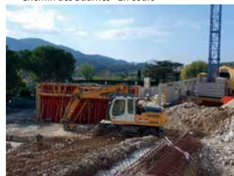
Rue Aristide Briand - En cours
