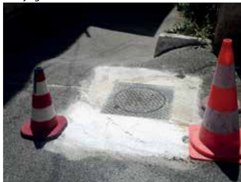
Maçonnerie Calade Saint Eloi
