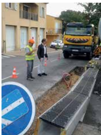
Avenue de la Libération - En cours
