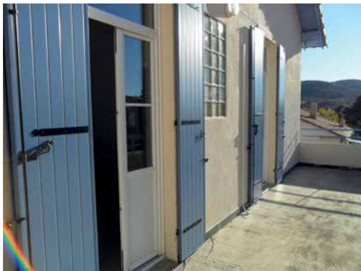
Centre Technique Municipal - Après
