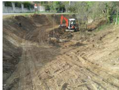
Débroussaillage chemin de l'Argile
