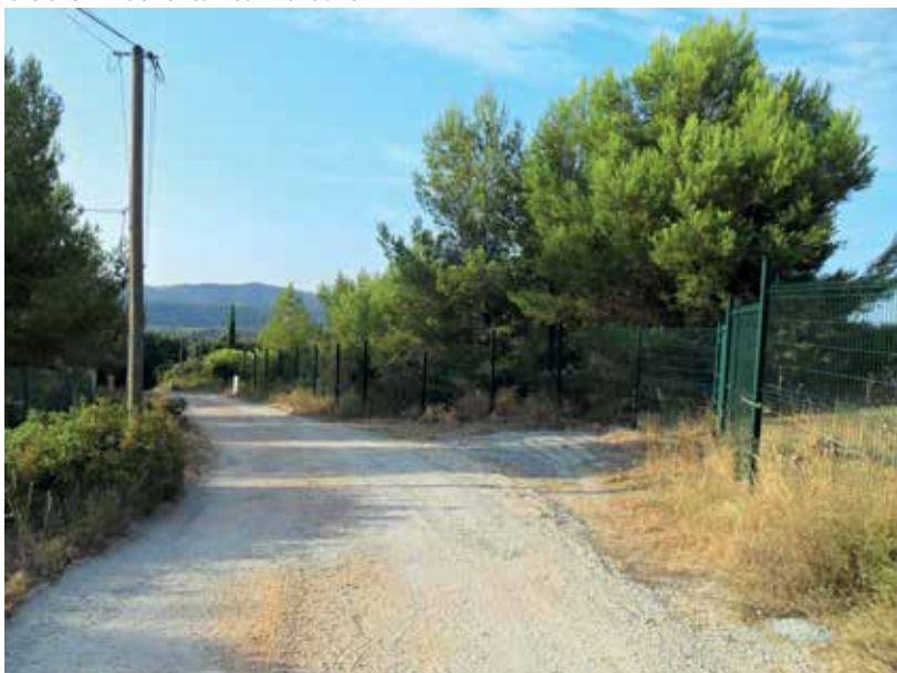
Revêtement chemin de la Toussane - Après
