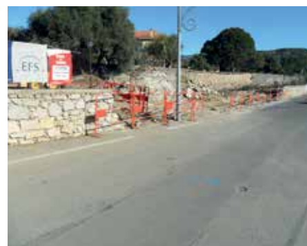
Chemin des Baumes - En cours
