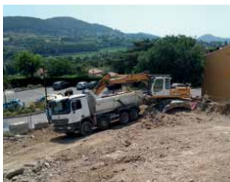
Rue Aristide Briand - En cours
