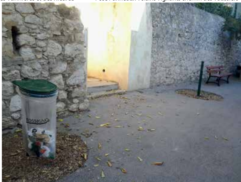
Pose Bancs - Cendriers urbains - Poubelle rue Paul Bert
