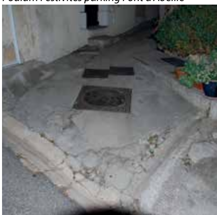
Maçonnerie rue Blanquerie - Avant
