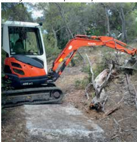
Elagage et maçonnerie chemin des Ladres - Pendant
