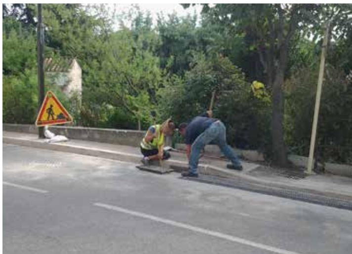
Entretien avaloirs pluvial avenue de la Libération
