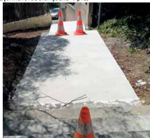
Maçonnerie les Valouches - Après
