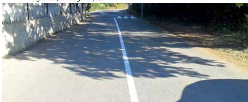
Signalisation routière horizontale - Après
