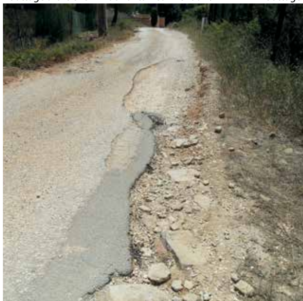
Revêtement chemin de la Toussane - Avant
