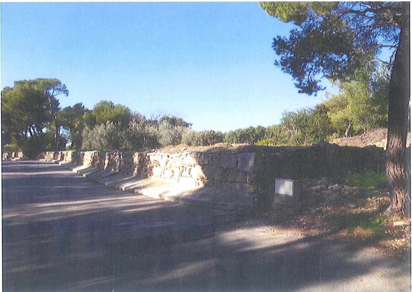
Photo 4 : Mur de soutènement créé le long du chemin Saint Marc, remblaiement arrière sur 4 à 5 m de profondeur.
