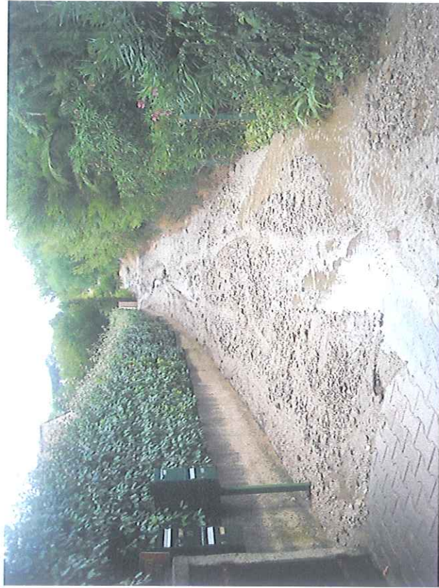
Lotissement L'Aumade : où l'on voit les dégâts causés par le ravinement du chemin, notamment la boue
