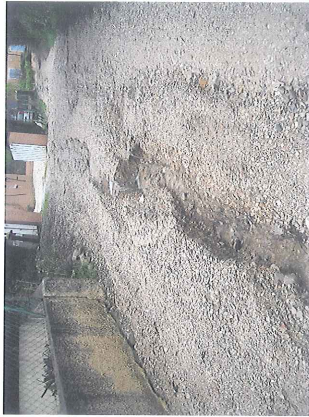
Lotissement L'Aumade : où l'on voit les dégâts causés par le ravinement du chemin, notamment la boue
