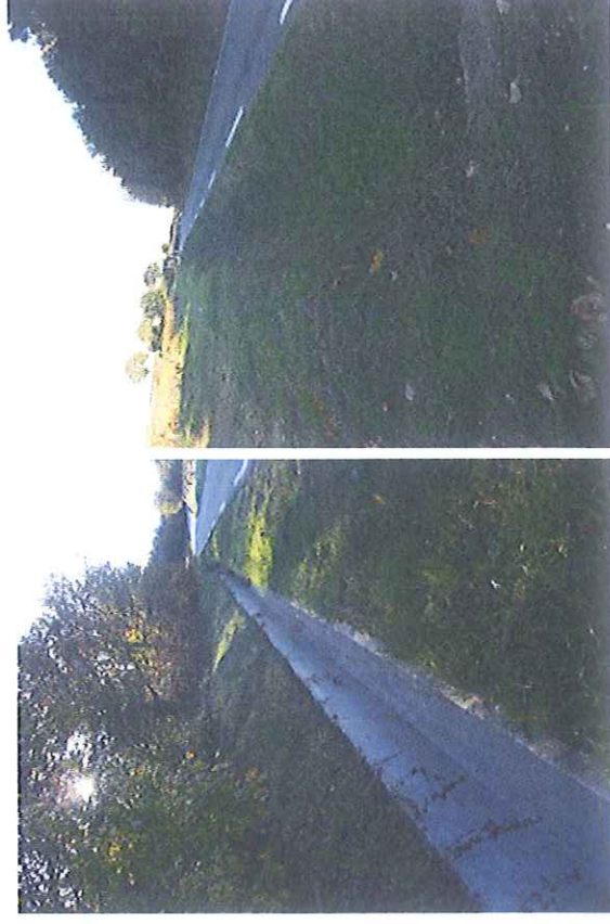
Fossé canalisé et enherbé – Source : Terres et Territoires
