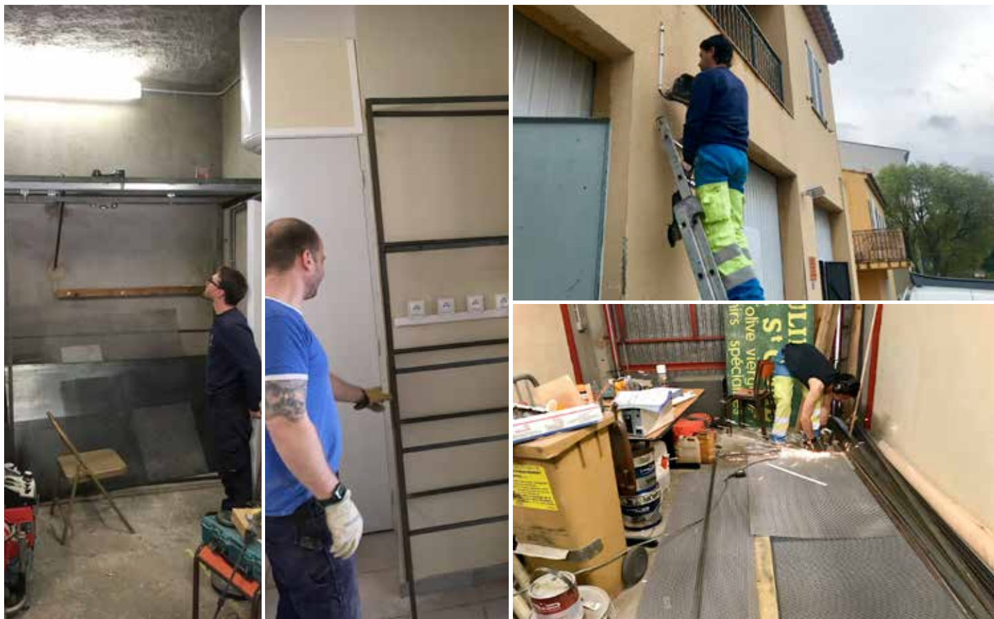
Rénovation local Comité Communal Feux de Forêt avenue de la Libération - Pendant
