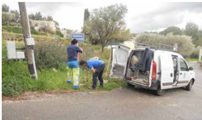
Pose panneau signalisation voirie chemin des Belles Pierres - Pendant
