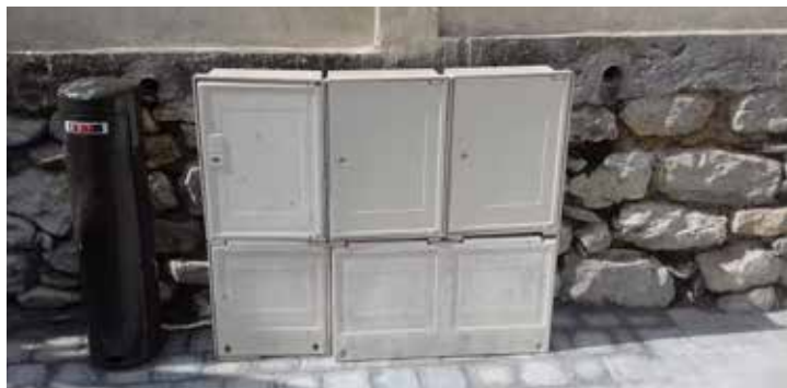
Pose potelés pour protection borne électrique Place des Consuls - Avant
