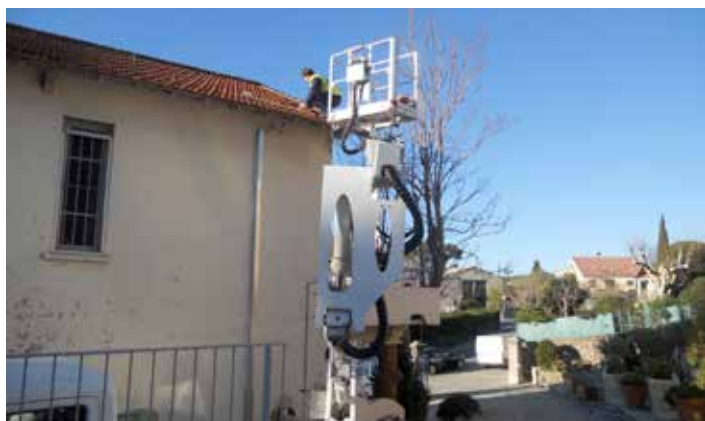
Reprise tuiles et gouttières toiture Centre Technique Municipal - Pendant
