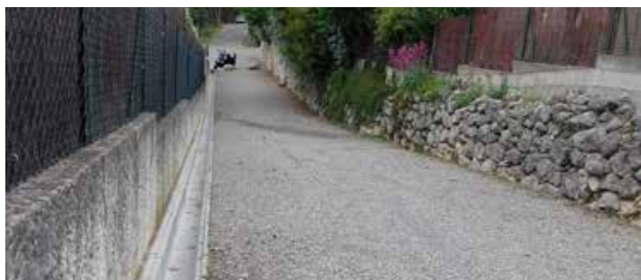
Débroussaillage et nettoyage caniveau pluvial chemin piétonnier de Saint Marc - Après
