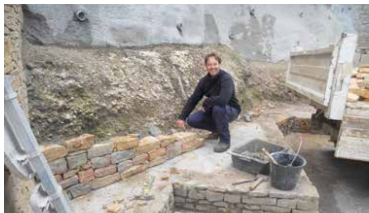
Réalisation d'une jardinière sous barre rocheuse avenue Jansoulin - Pendant
