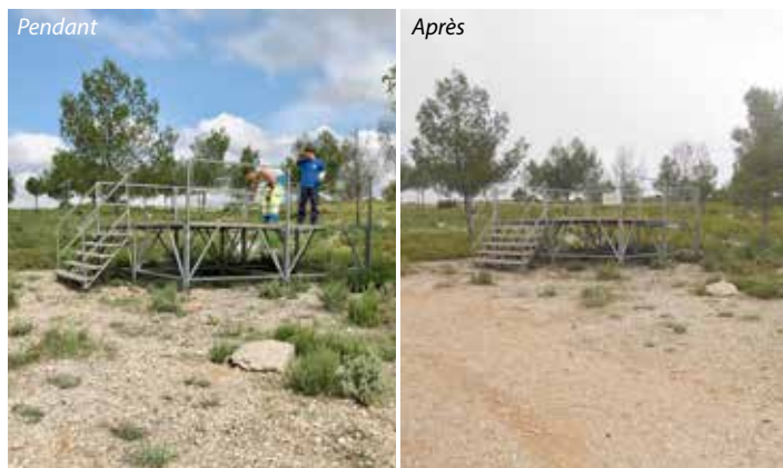
Installation podium Complexe Sportif Francis Itrac
