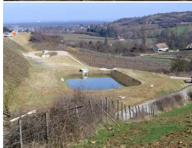
Bassins de rétention des eaux pluviales à la Cadière d'Azur et à Moroges Source : Terres et Territoires et www.saint-desert.fr
