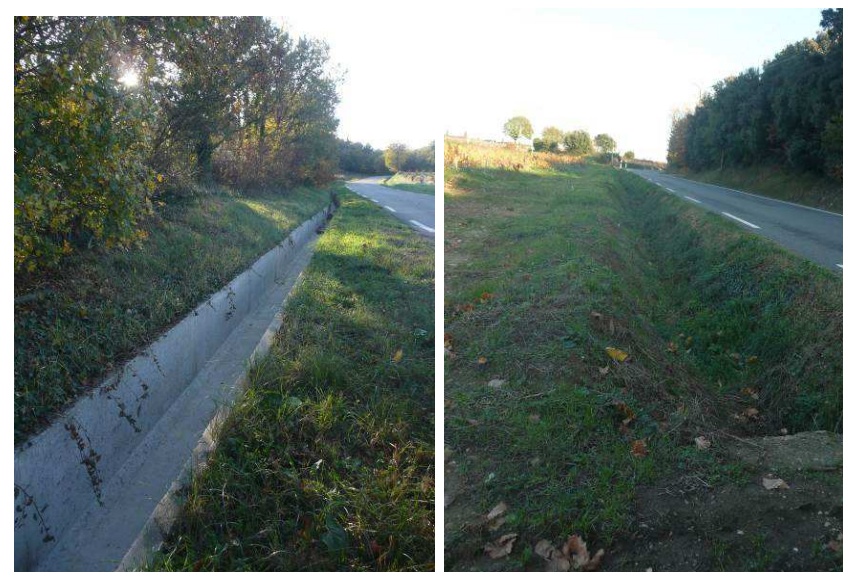
Fossé canalisé et enherbé – Source : Terres et Territoires
