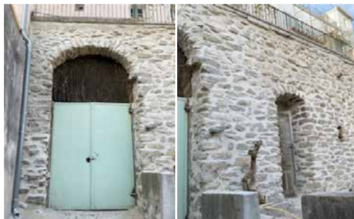
Mairie annexe - Après
