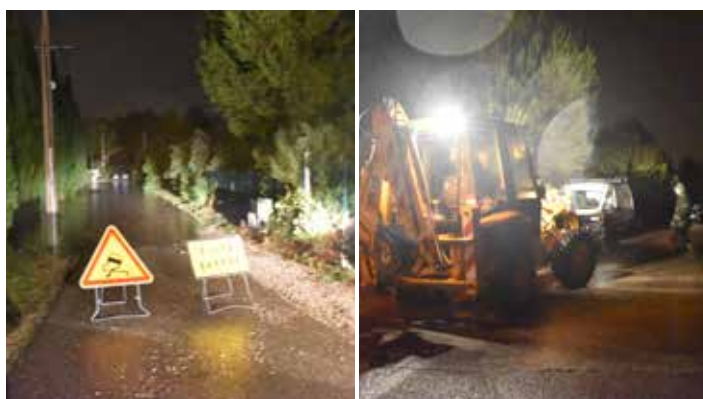
Intervention suite aux intempéries chemin des Belles Pierres - Pendant
