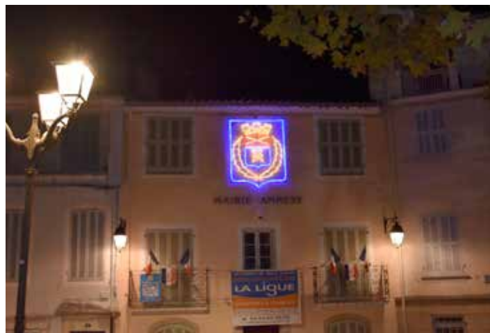
Mairie annexe - Après
