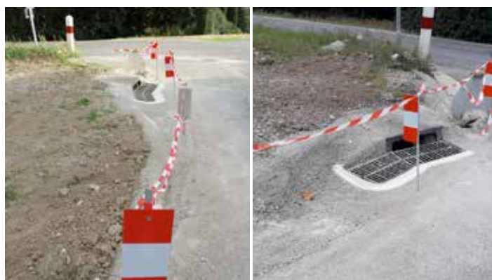
Reprise caniveau grille et avaloir pluvial chemin des Luquettes - Après
