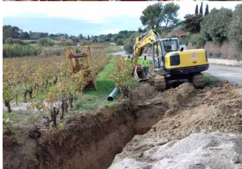
Réseau collectif des eaux usées - Pendant
