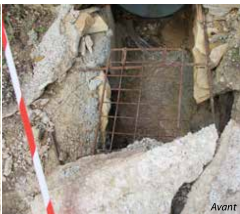
Reprise buse pluvial suite à affaissement chemin des Vannières et des Ricards
