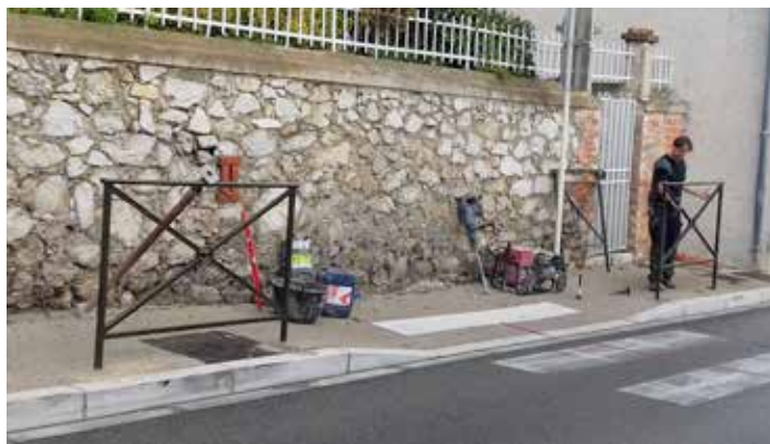
Changement barrières déformées avenue de la Libération - Pendant
