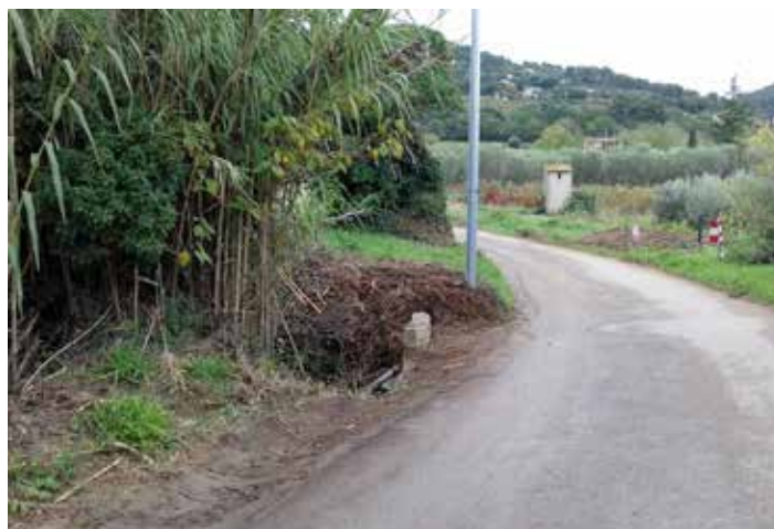
Débroussaillage pour visibilité routière chemin des Arnauds - Après
