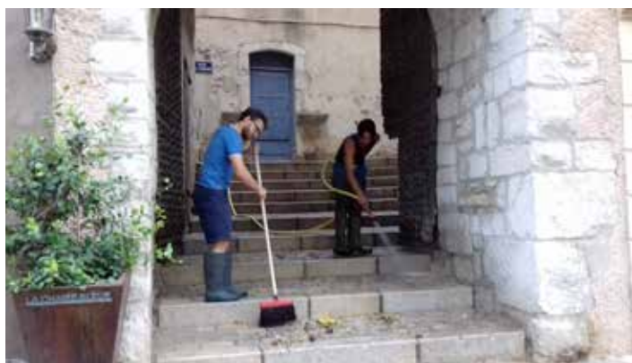
Nettoyage Porte Saint Jean - Pendant
