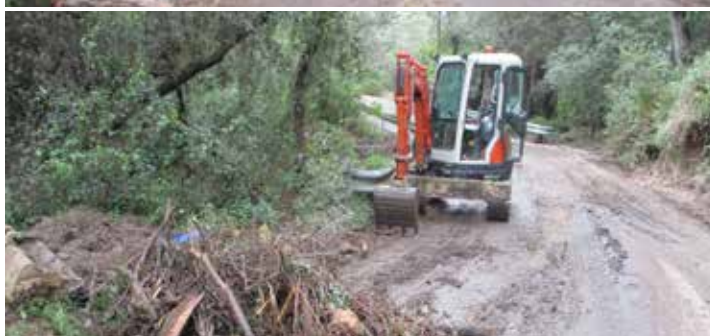
Intervention suite aux intempéries chemin de la Péguière - Pendant
