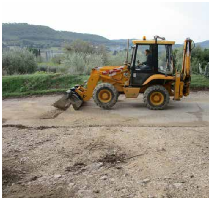
Intervention suite aux intempéries chemin de la Bégude - Pendant
