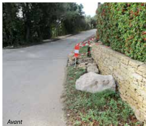
Reprise buse pluvial suite à affaissement chemin des Vannières et des Ricards
