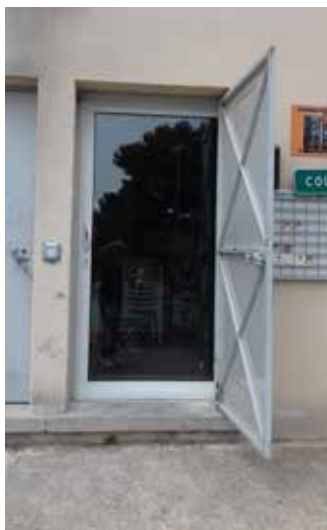
Pose porte supplémentaire local Tennis Club
