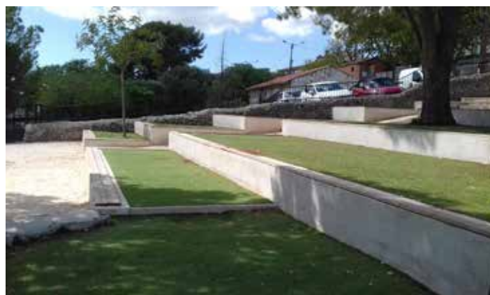
Entretien aire de jeux et de repos chemin des Baumes
