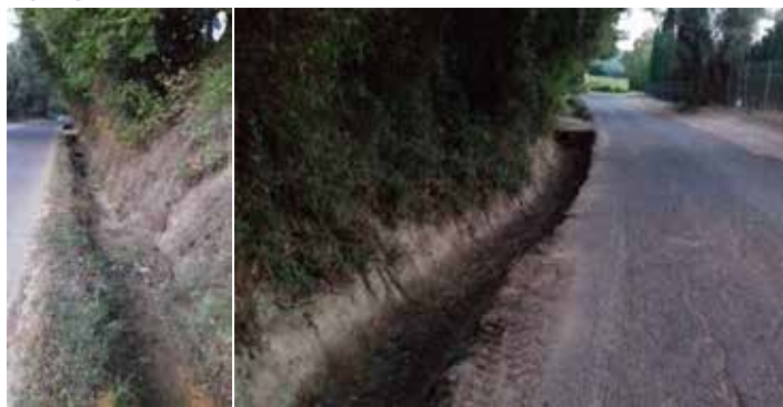
Entretien réseau pluvial chemin de la Malissonne
